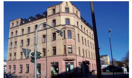
Neue Arbeit Chemnitz, Hainstraße
