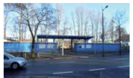
neuer Eingang des CFC-Stadions
